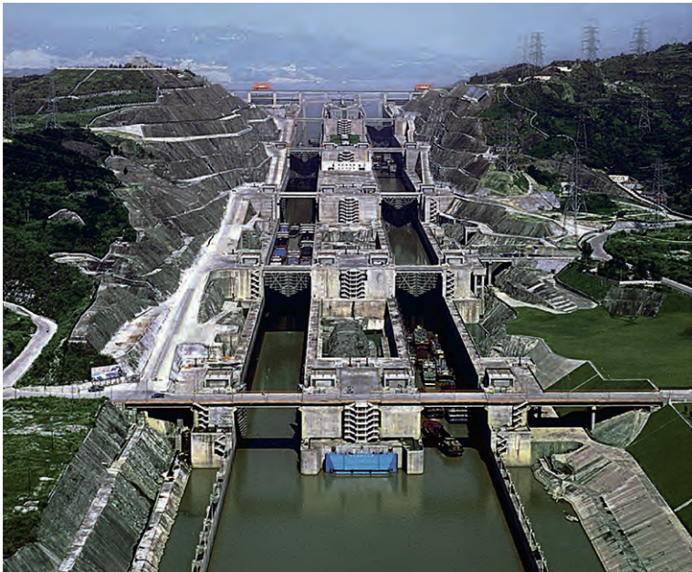
Slussleden som tar fartygen förbi världens största vattenkraftsanläggning Three Gorges (tre klyftor) i Yangtze-floden i Kina. Anders uppdrag var bergteknisk rådgivning för preliminär design av slussleden.
